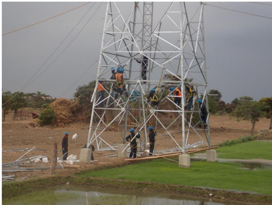
Ilustración 1- Construcción de una torre de una línea de transmisión de 138 kV en Lambayeque.
