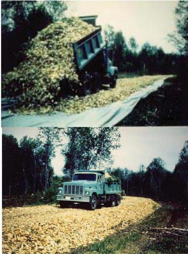
Ilustración 6- Trocha hecha con geotextiles y astillas.
