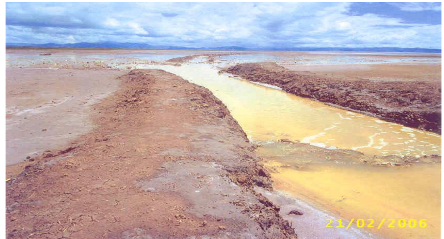
Vista del canal construido por los comuneros que vierte el agua de formación del pozo RH 10 a orillas del Lago Titicaca.
